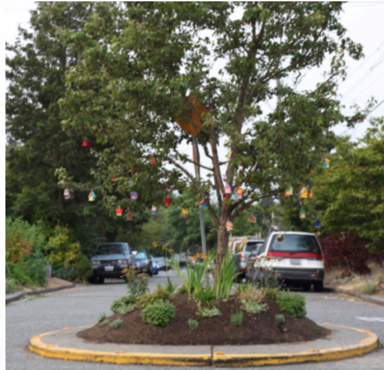
Mini Traffic Circle - Concrete
