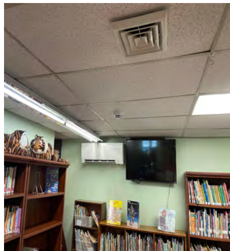
Figure 2 - Basement Mini Split
