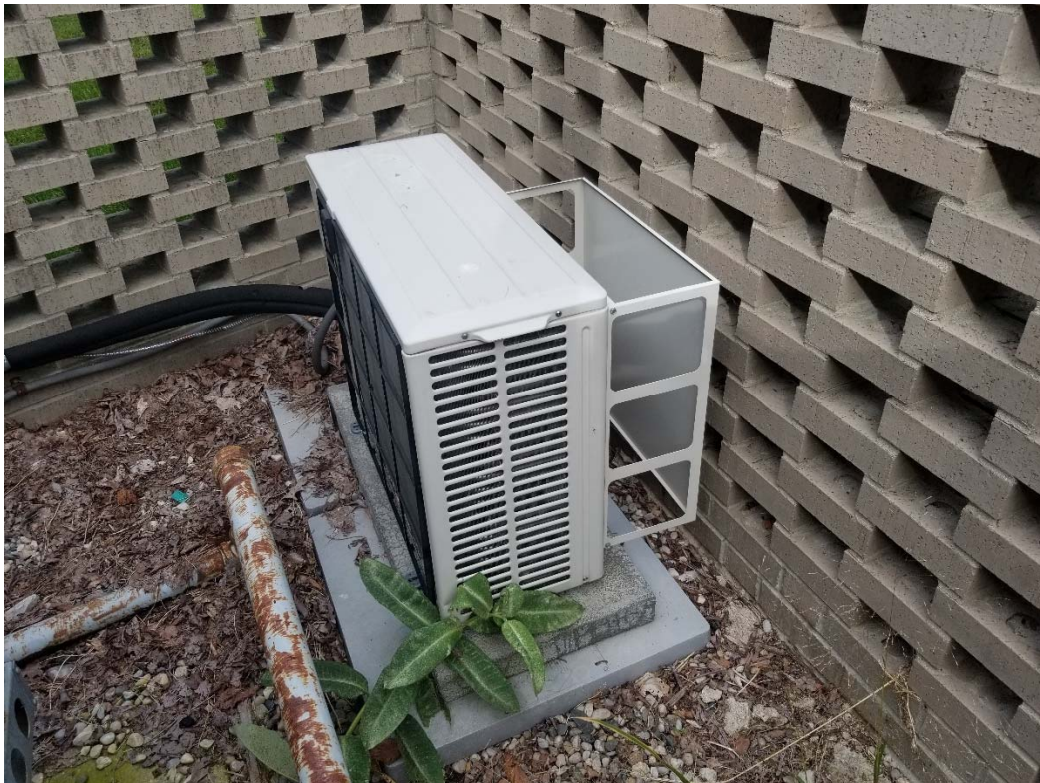
M10 Condensing Unit
