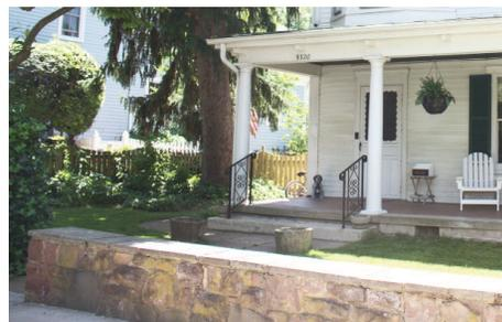
La piedra arenisca roja, extraída localmente en el siglo XIX y utilizada extensamente para cimientos y en algunos casos como único material de construcción para estructuras, también se utilizó para construir muros frente a algunas residencias. Igualmente se han utilizado ladrillos y otros tipos de mampostería para muros de contención.
