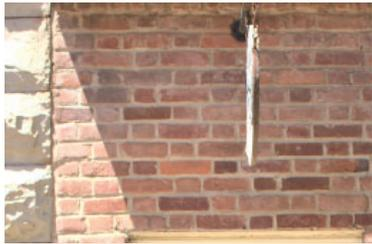
El ladrillo moldeado es un ladrillo previamente hecho a mano que no es tan denso como el ladrillo prensado o extruido exterior.
