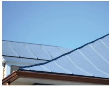
Los tejados de metal están hechos de acero galvanizado, estaño u ocasionalmente cobre. Este material se utiliza en forma de láminas enrolladas con costuras alzadas. Los tejados de metal siempre se pintan a menos que sean de cobre. Los tejados de metal se encuentran en edificios comerciales y residenciales. Aproximadamente la mitad de todos los tejados residenciales están cubiertos con metal, ya sea con costura alzada o con tejas de metal.
