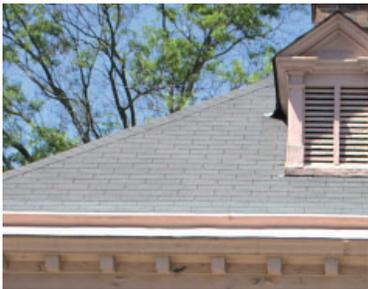
Las tejas de asfalto son fieltro impregnado de asfalto cubierto con gránulos de cerámica o piedra de colores. Las tejas de asfalto son el segundo material de revestimiento de tejados más popular en la zona. El uso de estas tejas de composición indica que se trata de un edificio de principios del siglo XX o que el material del tejado se reemplazó en un momento posterior.
