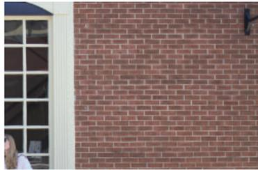
El ladrillo prensado es más denso y liso que el ladrillo moldeado y es evidente en varios edificios comerciales del distrito de Manassas.
