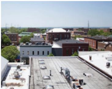
Los tejados fabricados están hechos de capas de brea o fieltros de capas saturadas de asfalto sobre cubiertas y aislamiento. Los tejados de muchos edificios comerciales tienen este diseño.
