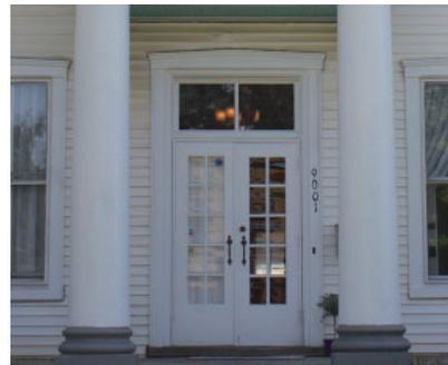
Las ventanas sobre el travesaño suelen ser ventanas curvas, cuadradas, equilibradas o asimétricas que cuelgan sobre el travesaño de una ventana o puerta. Originalmente, las ventanas sobre el travesaño se usaban para mejorar la ventilación y aumentar la luz natural dentro de un edificio.
