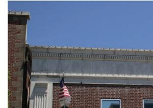
Albardilla es donde no hay cornisa en la parte superior de una pared de parapeto, y se usa un material como concreto, piedra, ladrillo o metal para cubrir la parte superior de la pared.
