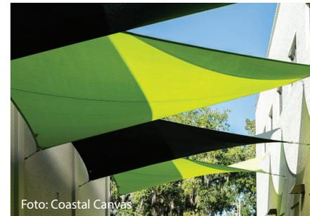
Los toldos removibles (también conocidos como toldos de vela) generalmente se instalan con un mecanismo de anclaje permanente a un edificio. Estos toldos de tela se configuran y desmontan manualmente para uso estacional según las condiciones climáticas.
