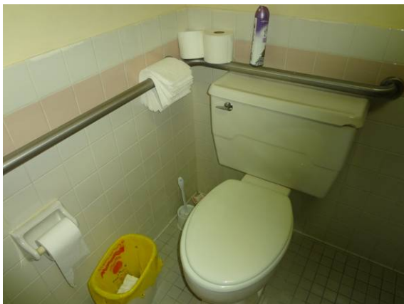
Photo #35: Water closet in tenant unit
